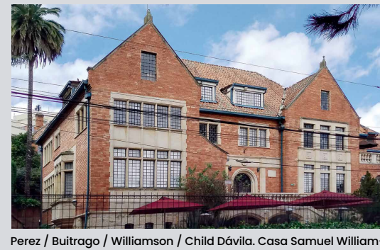
Pérez / Buitrago / Williamson / Child Dávila. Casa Samuel Williamson Ramírez (1936). Pérez / Buitrago / Williamson / Child Dávila. Samuel Williamson Ramírez House (1936).
