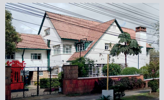
Cuellar Serrano Gómez. Casa Umaña de Meoz (1945). Cuellar Serrano Gómez. Umaña de Meoz House (1945).
