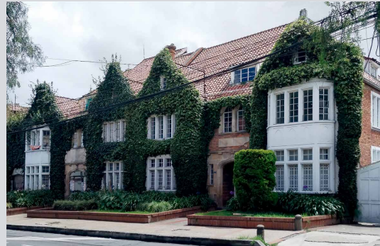
Rocha / Santander. Casa Fernando Pombo (1943). Rocha / Santander. Fernando Pombo House (1943).
